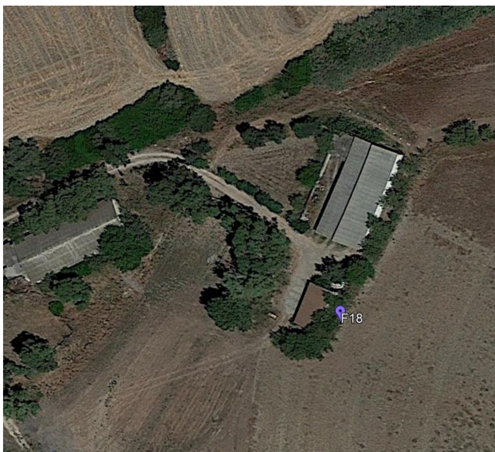
Figura 6.2 – Cortina arborea posizionata a sudest del ricettore F18. La barriera verde esercita un efficace effetto schermante sul potenziale ombreggiamento intermittente esercitato dagli aerogeneratori V3, V4 e V7
