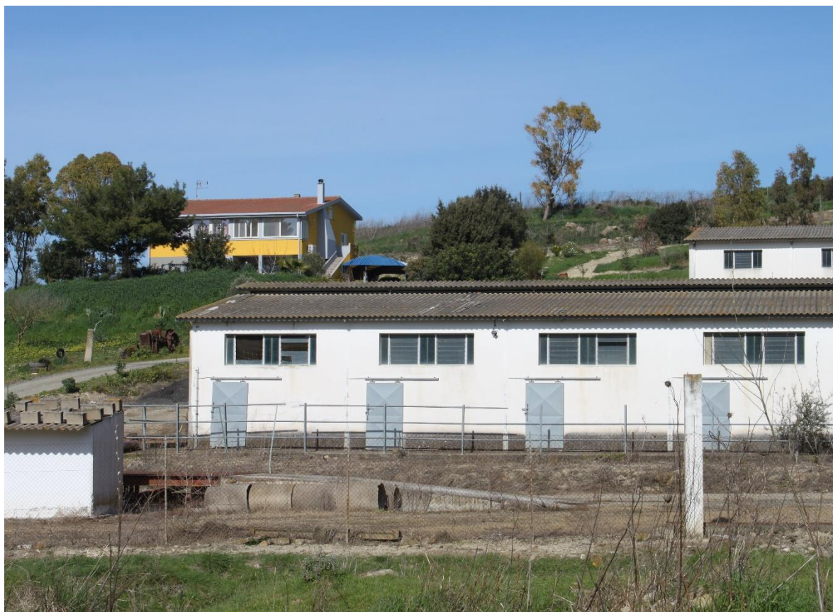
Figura 6.5 – Edificio F23 (vista da sudest)
