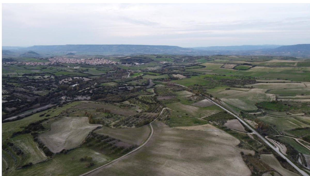
Figura 6.10_Coltivazioni di olivo e mandorleti in lontananza e fasce di eucalipti. Foto scattata in prossimità della postazione eolica V2.
