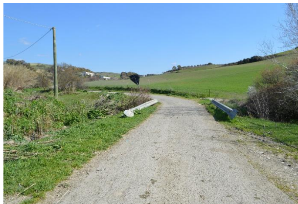
Figura 3.65 - Viabilità asfaltata esistente
