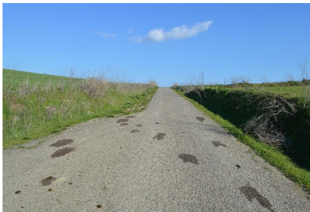
Figura 3.64 – Viabilità asfaltata esistente
