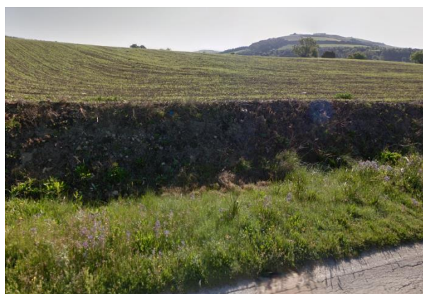
Figura 3.71 - Area di manovra. Vista NW → SE
