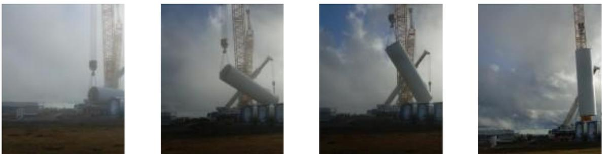
Figura 5.3\_Schema delle fasi di sollevamento dei componenti dell'aerogeneratore (Fonte sito web <http://www.windfarmbop.com/>)
