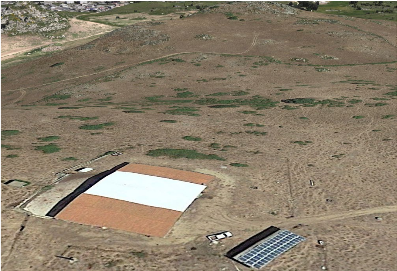
Figura 12 Punto 6 Ripresa area impianto (edificio rurale)
