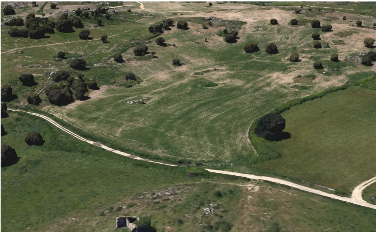
Figura 9 Punto 3 di presa area impianto agrivoltaico
