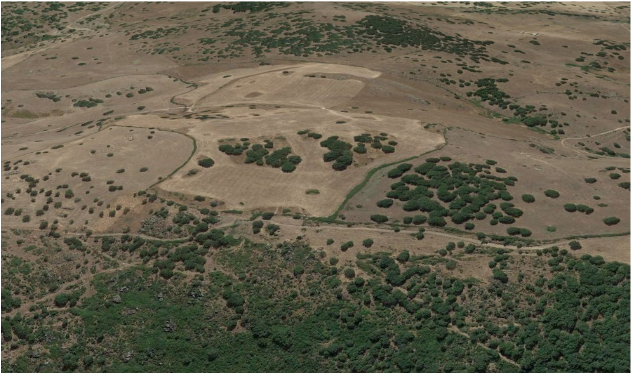
Figura 7 Punto 1 di presa area impianto agrivoltaico
