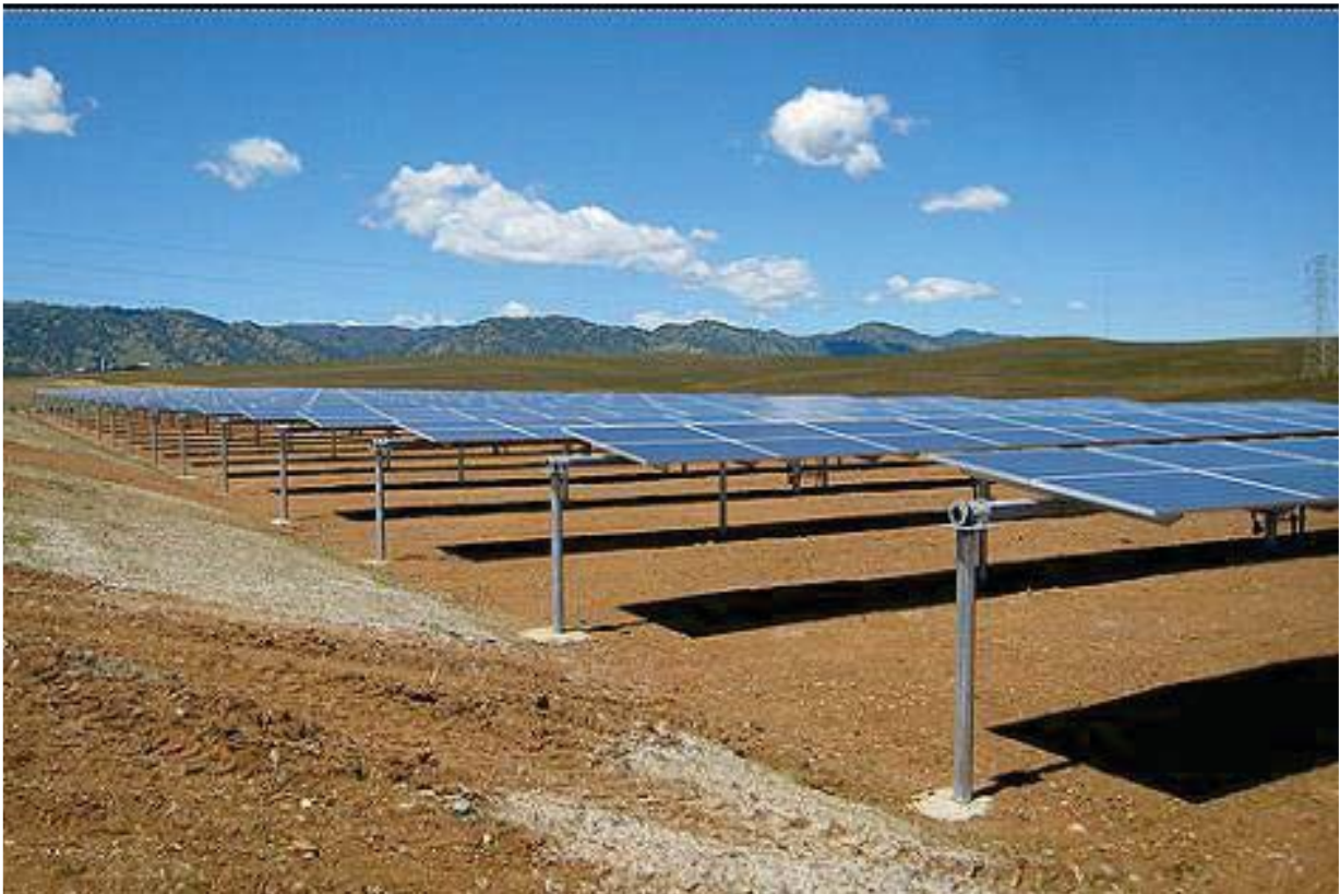
Figura 5: Rappresentazione della struttura di supporto
