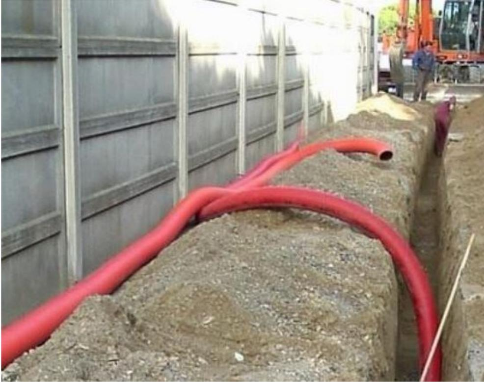
Figura 6 - scavo per elettrodotti interrati
