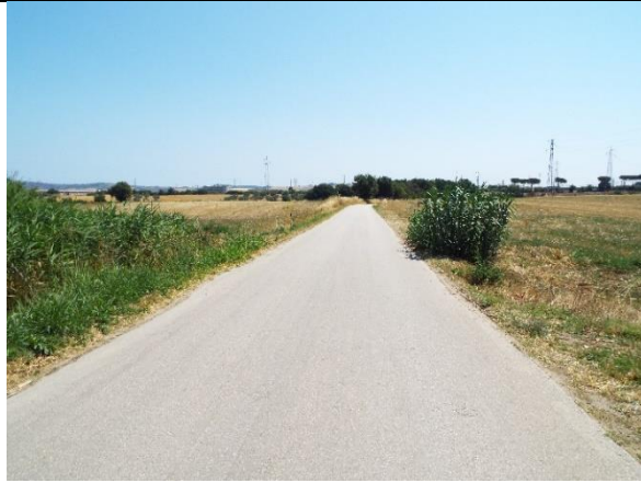
parte asfaltata (ad ovest della SS 87)
