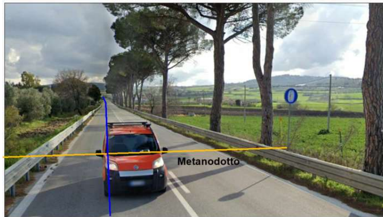
Figura 31: Attraversamento con metanodotto (scatto direzione NNE-SSW), interferenza I14
