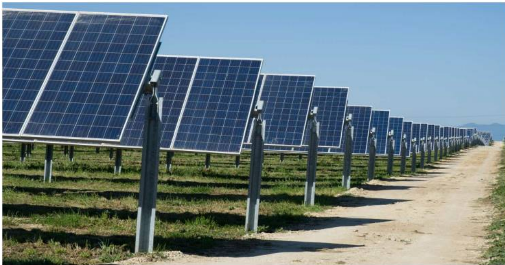
Figura 2: Struttura mobile ad inseguitore solare portamoduli TRACKER
