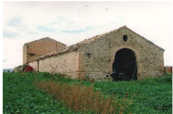
Sito 6: Masseria Castello
