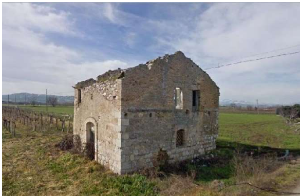
Sito 5: Casa Travaglini-Campitelli
