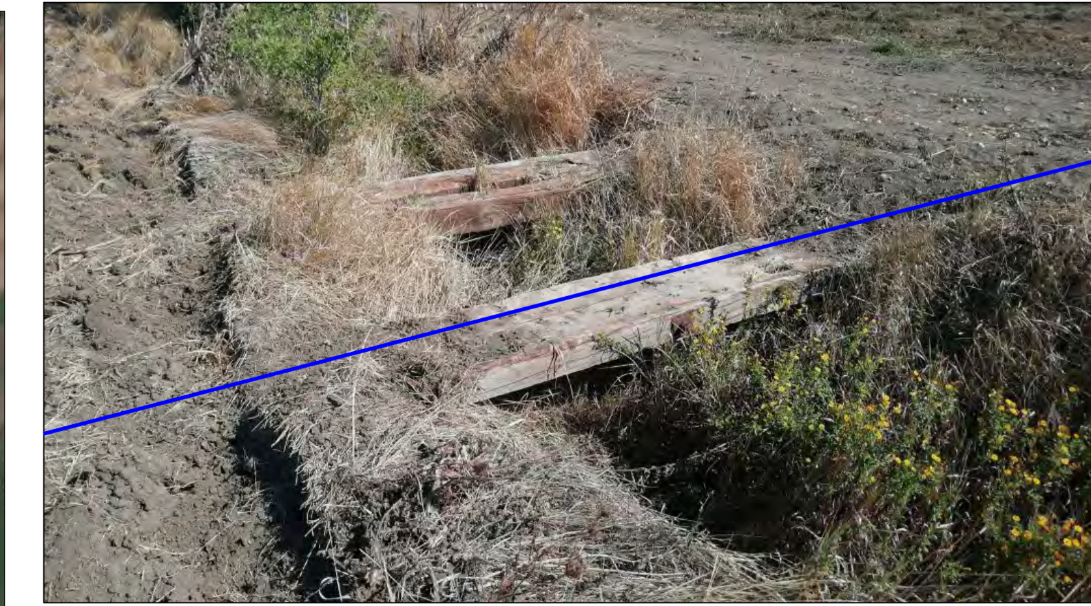
Interferenza I03: attraversamento reticolo idrografico e condotta del Consorzio di Bonifica. Foto da rilievo in sito
