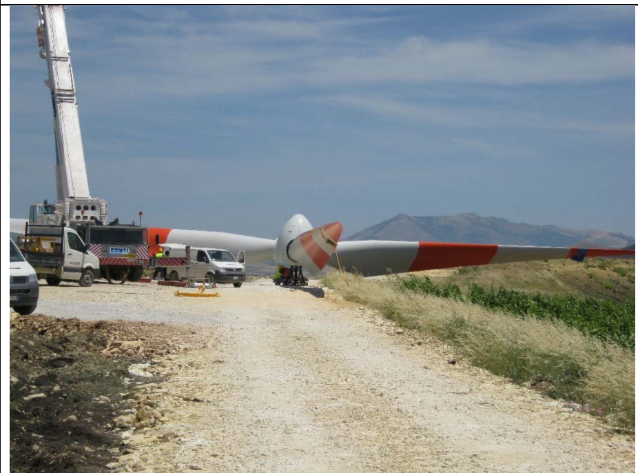
Particolare del supporto in acciaio su cui è collocato il rotore – Fonte HE
