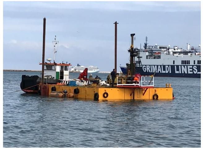
Foto 9: Sondaggio a mare carotiere a rotazione
