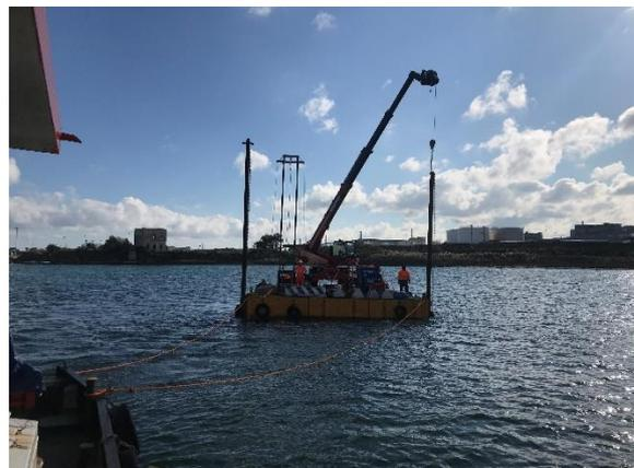
Foto 5: Movimentazione vibrocarotiere
