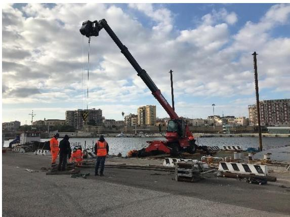
Foto 4: Assemblaggio vibrocarotiere
