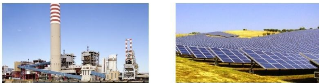
Figura 69. Confronto tra centrale termica e campo fotovoltaico
