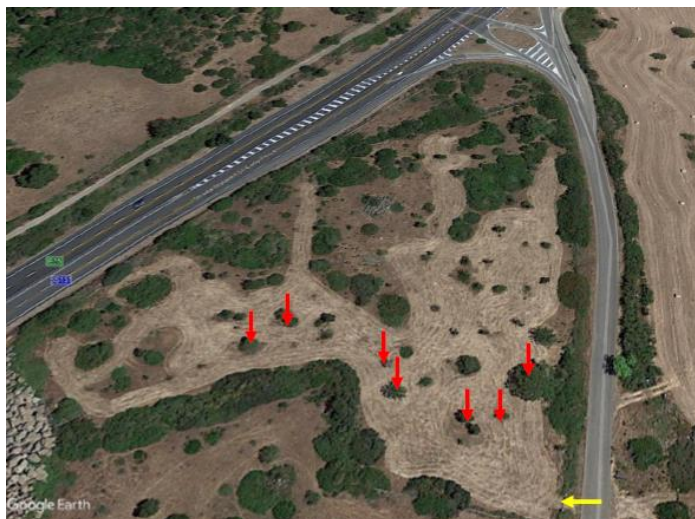
Figura 8 – Essenze arboree di pregio da espianare e mettere a dimora temporanea (freccia rossa); la freccia in giallo indica l'esistente accesso privato su via Nazionale che sarà utilizzato come varco di accesso principale al campo base.
