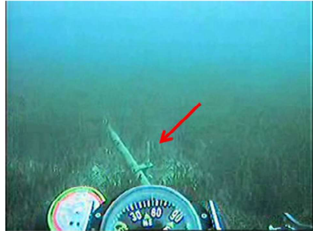
Esempio di cavidotto sommerso su prateria a P. oceanica (le frecce indicano i collari di serraggio)
