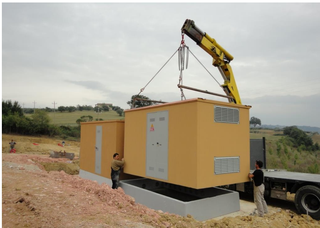
Installazione cabine elettriche prefabbricate
