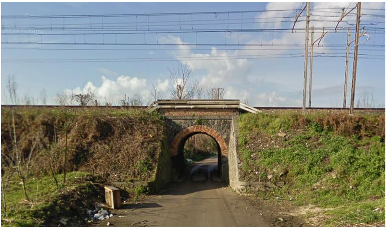
Sottopassaggio linea ferroviaria
