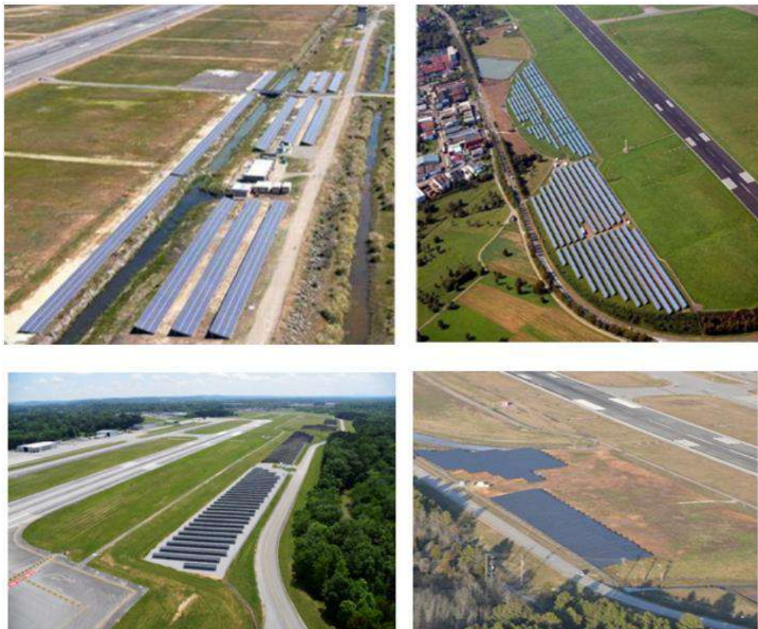
Figura: Esempi di impianti fotovoltaici in ambito aeroportuale. La disposizione dei moduli fotovoltaici in prossimità delle piste di atterraggio/decollo non rappresenta un rischio per la sicurezza
