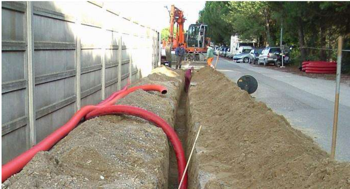
Cantiere per linea elettrica di media tensione interrata su strada asfaltata
