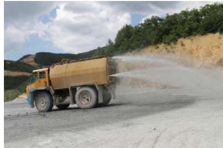
Esempio di Irrorazione delle aree di cantiere.
