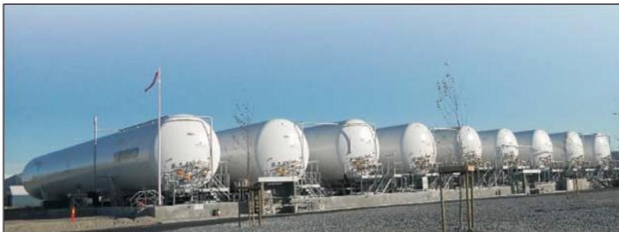
**Figura 27** - Esempio di serbatoi criogenici (impianto GNL a Fredrikstad – Norvegia)
