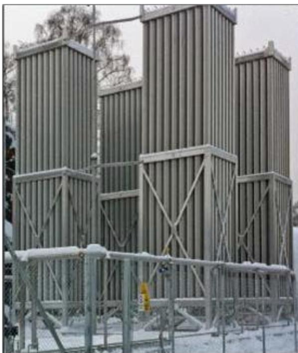
**Figura 34** - Vaporizzatori AAV
