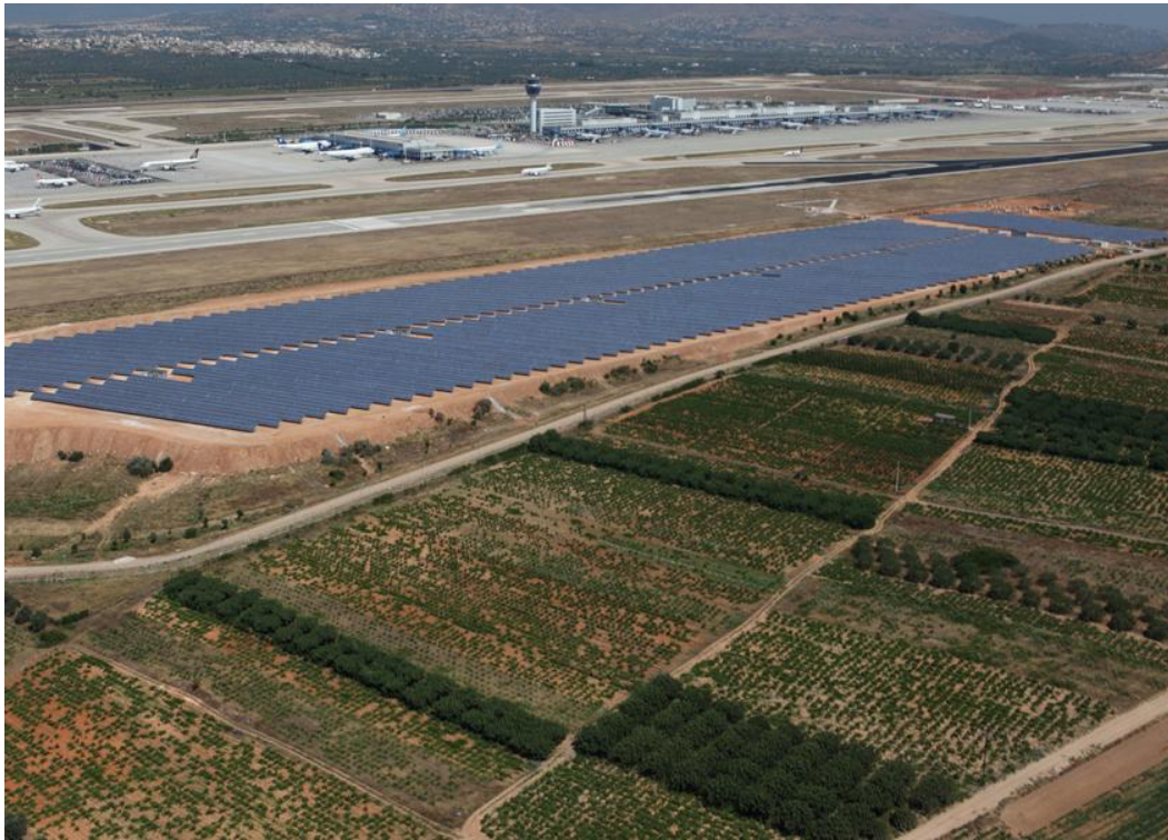
Fig. 6 : Aeroporto di Atene con impianto fotovoltaico
