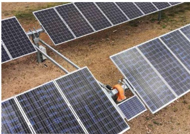
Il tracker monoassiale è di tipo orizzontale ad asse singolo ed utilizza dispositivi elettromeccanici per inseguire il sole durante tutto il giorno da est a ovest sull'asse di rotazione orizzontale nord-sud (inclinazione 0°).
