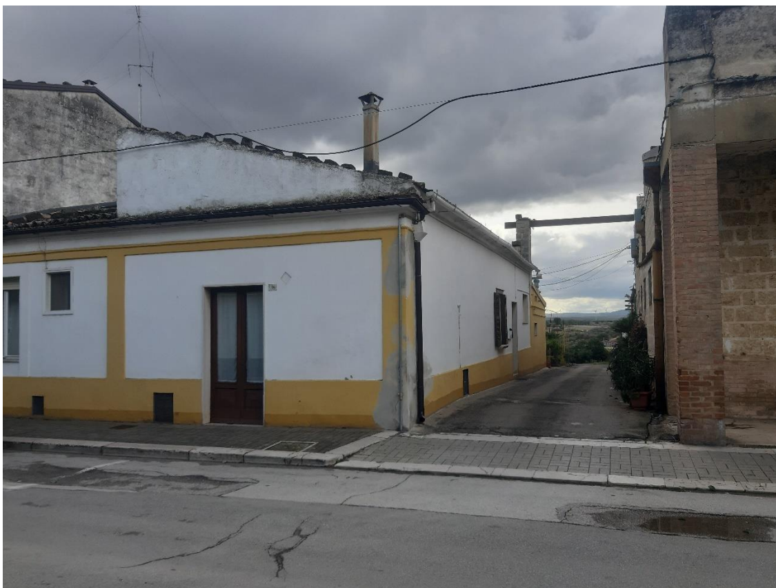
Foto 12a – Punto di Presa n° 12 Stato di Fatto
