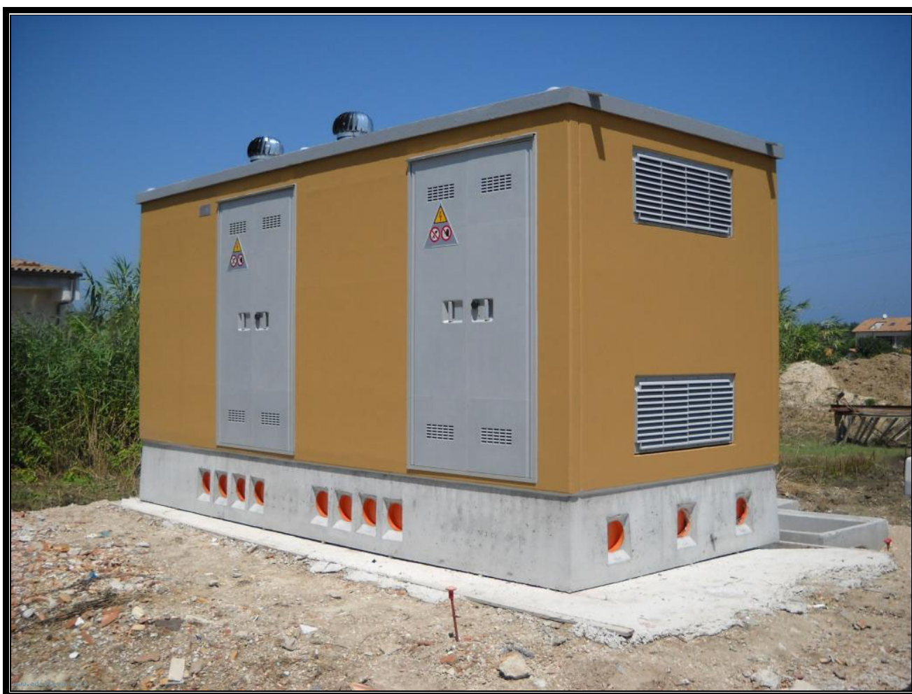
Figura 9 - ESEMPIO DI CABINA DI PARALLELO MT
