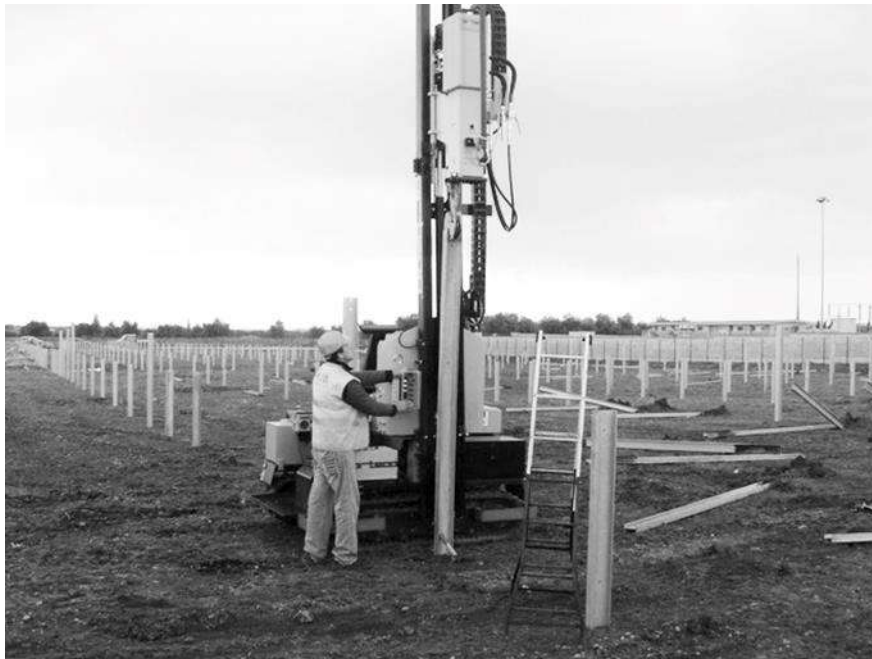
Figura 8: Esempio di fissaggio delle strutture di supporto
