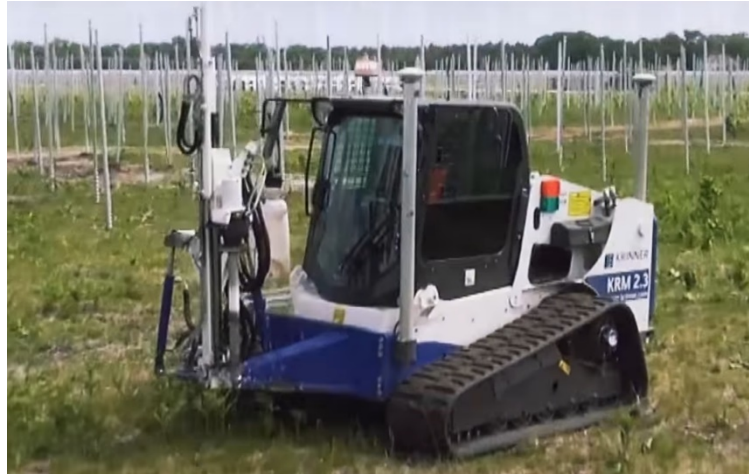
Figura 8. Esempio di fissaggio delle strutture di supporto
