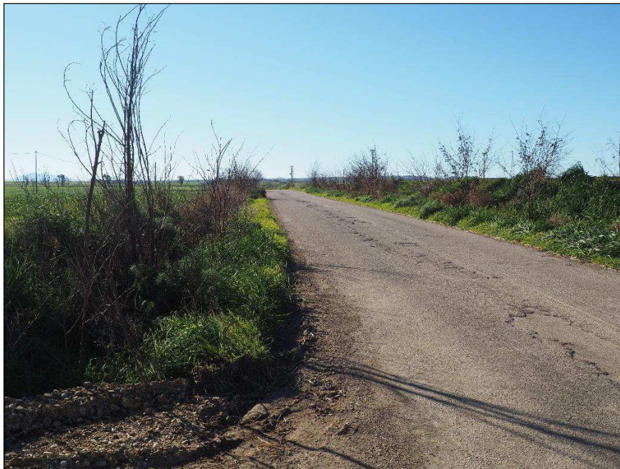
Foto 3.6 – visuale sud sud ovest
