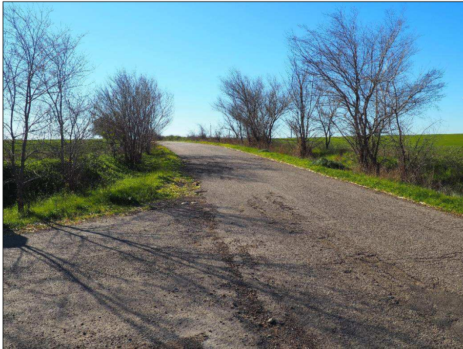
Foto 8.2 – visuale sud sud ovest
