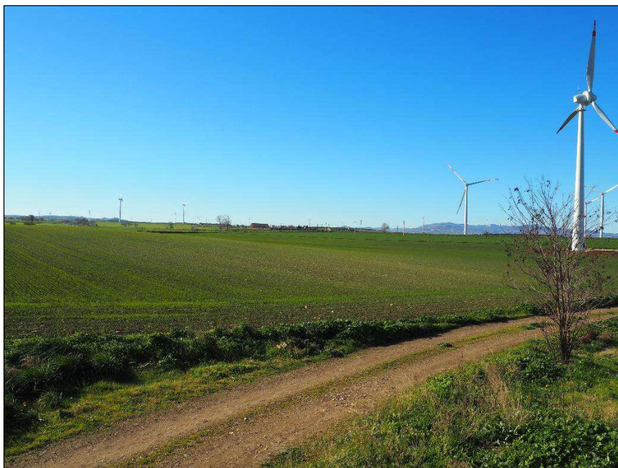
Foto 5.4 – visuale sud sud ovest
