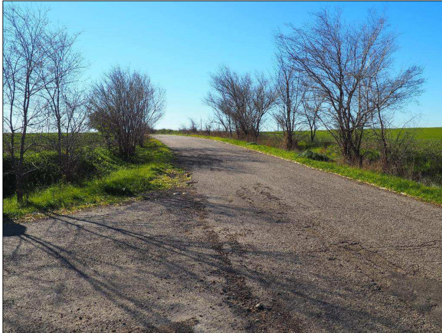
Foto 8.2 – visuale sud sud ovest
