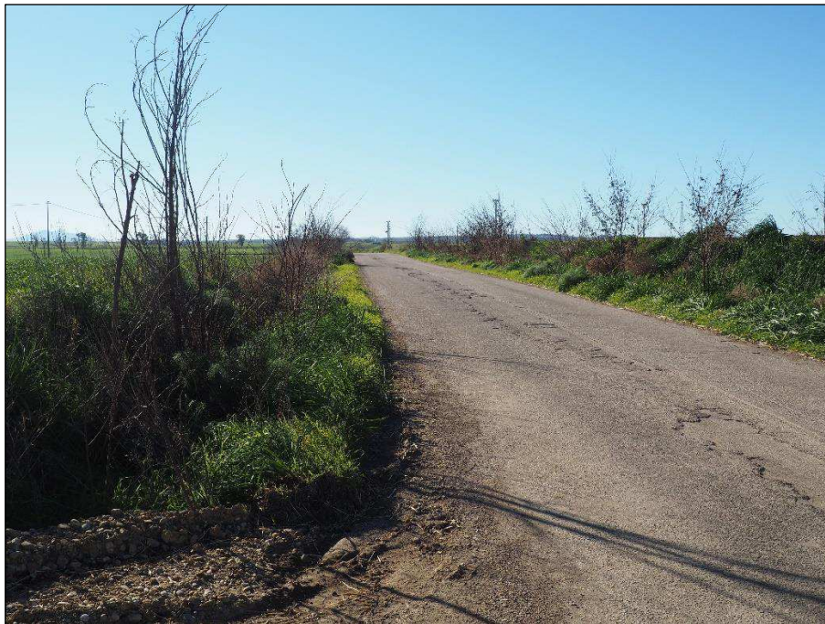
Foto 3.6 – visuale sud sud ovest
