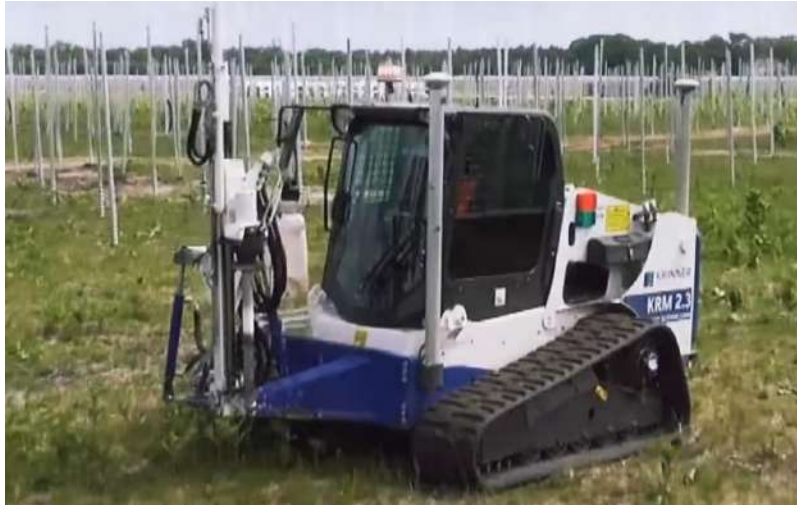
Fig. 45. Esempio di fissaggio delle strutture di supporto
