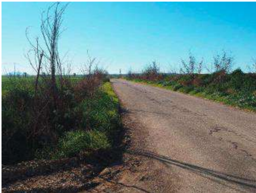
VISUALE SUD SUD OVEST
