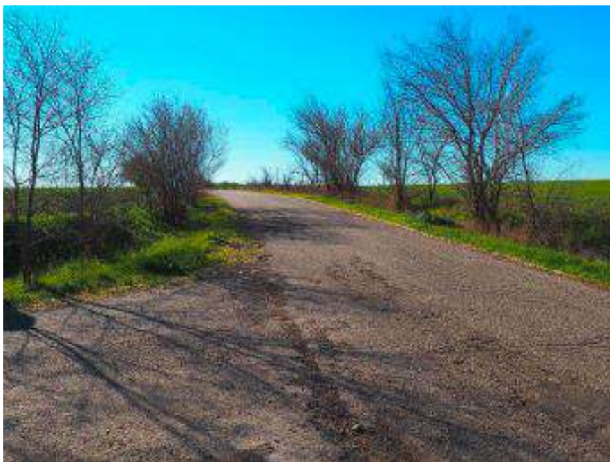
VISUALE SUD SUD OVEST
