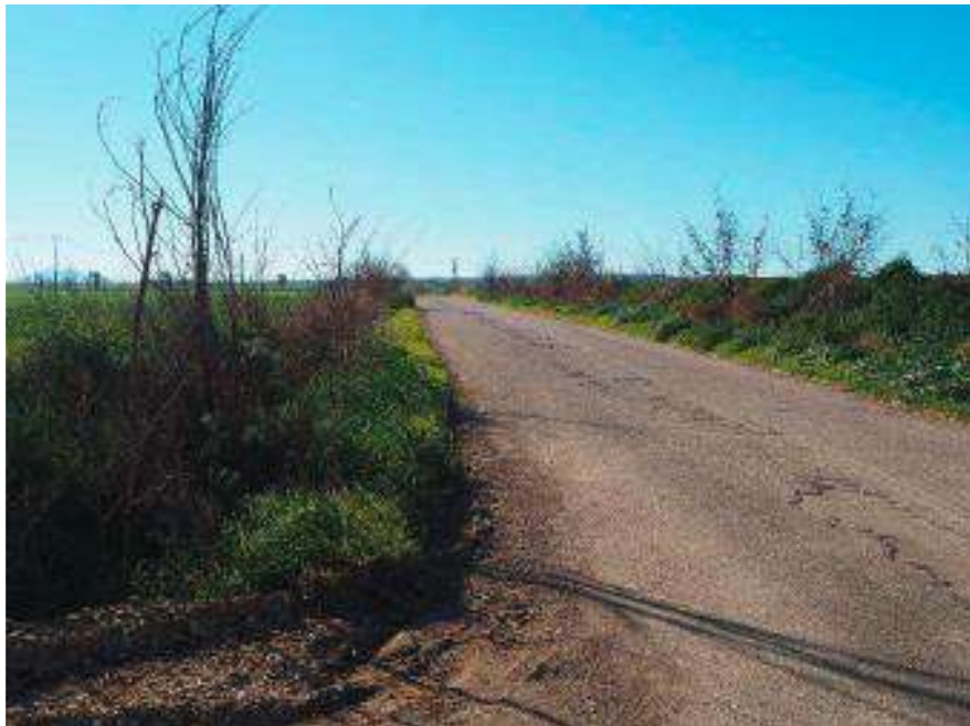
VISUALE SUD SUD OVEST
