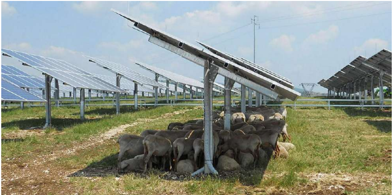
Fig. 17. Prato-pascolo aree poste sotto i pannelli
