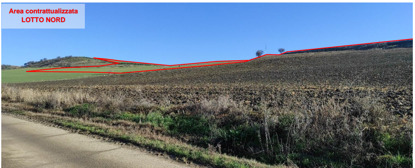
Vista Lotto nord (sistema fissi) impianto agrovoltaico "Atlante" da SP197
