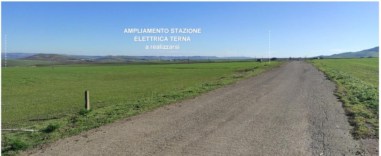
Ampliamento Stazione elettrica Terna 380/150 kV "Genzano" a realizzarsi - ANTE OPERAM
