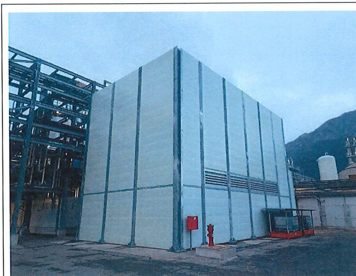
foto 1: vista dei lati SE e SO della barriera anti rumore alle torri frigo
