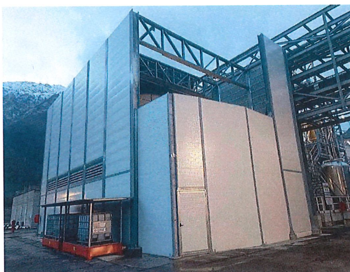
foto 3: vista delle torri frigo a fine lavori, con il completamento della parete fonoisolante davanti alle pompe
