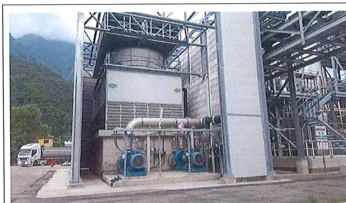
foto 2: vista dei silenziatori sopra i ventilatori delle torri frigo
