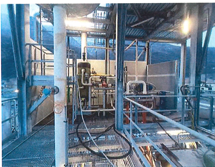
foto 5: parete anti rumore alla pompa del vuoto al 3° livello della piastra della potassa
