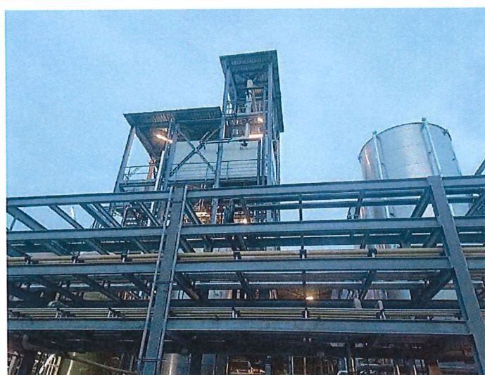
foto 6: vista da terra dell'insonorizzazione della pompa del vuoto del KOH
