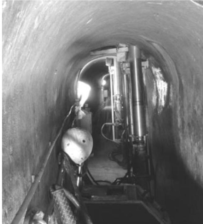
Figura 3 – Esempio posizionamento slitta di perforazione all'interno del cunicolo
