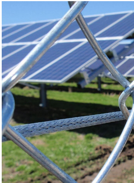
Figura 4.8 - Cavo in fibra ottica montato su rete metallica.
