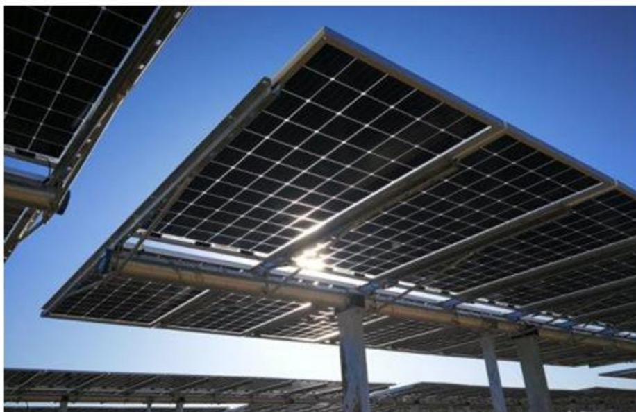
*Figura 2.2: Particolare strutture di sostegno moduli*
