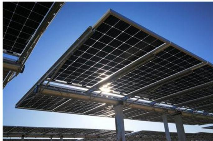
Figura 3.2: Particolare strutture di sostegno moduli
