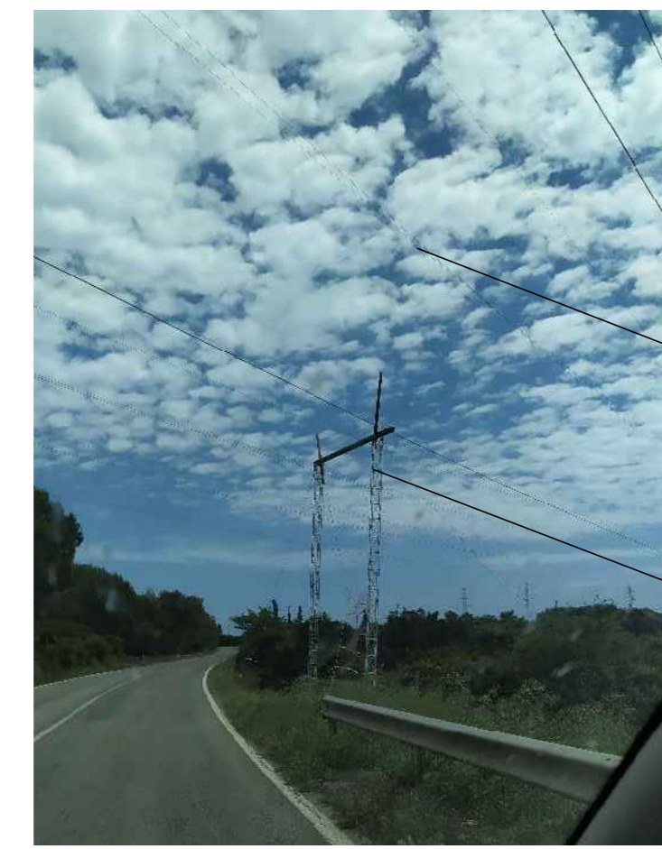
Cavi elettrici. Cavalletto per sollevamento cavi elettrici.
