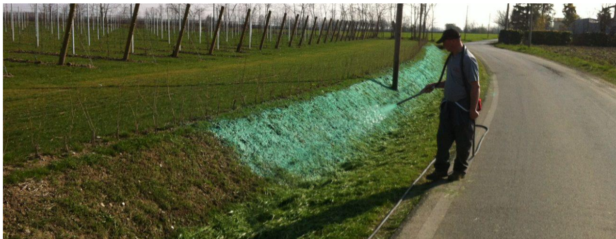
Figura 33 – Tecniche di idrosemina
