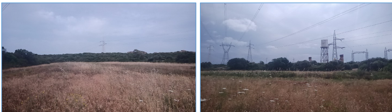
Figura I-3. Area di costruzione della SSEU. Terreno a pascolo/incolto, limitrofo ad una stazione elettrica pre-esistente.
