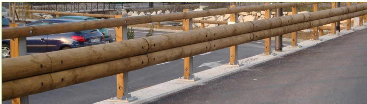
**Figura 23 – Barriere stradali H2 Bordo Ponte tipo Barriere in acciaio corten rivestite in legno**
