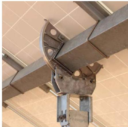
figura 8: schema nodo trave continua / colonna
