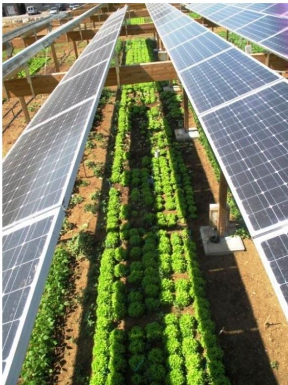
**Fig. 21 - Immagine di un impianto sperimentale Agro-Fotovoltaico**
