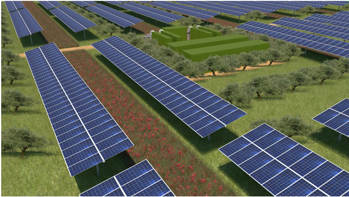
Fig. 27 - Mitigazione e Colorazione Cabine interne all’Impianto Agro-Fotovoltaico
