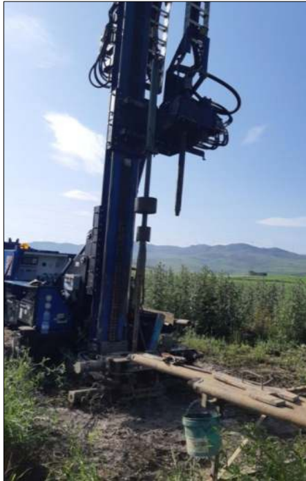
particolare prova SPT
