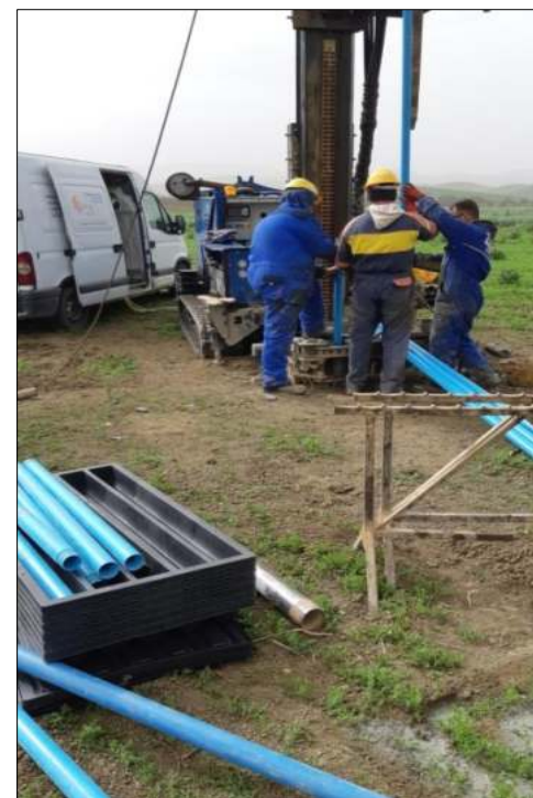
fase posa piezometro
