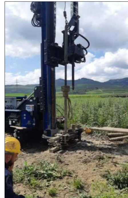
particolare prova SPT
