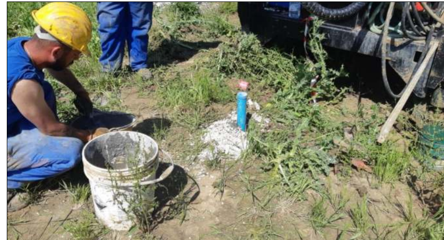
fase ultimazione posa piezometro
