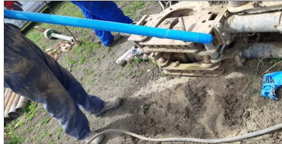
particolare piezometro in pvc atossico installato
