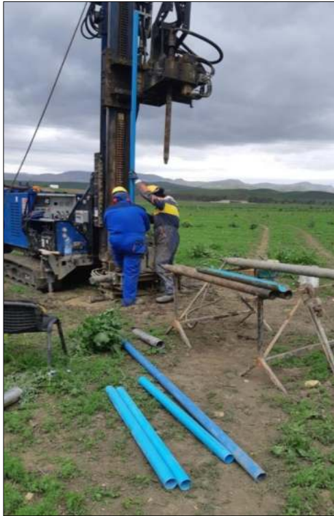
fase posa piezometro
