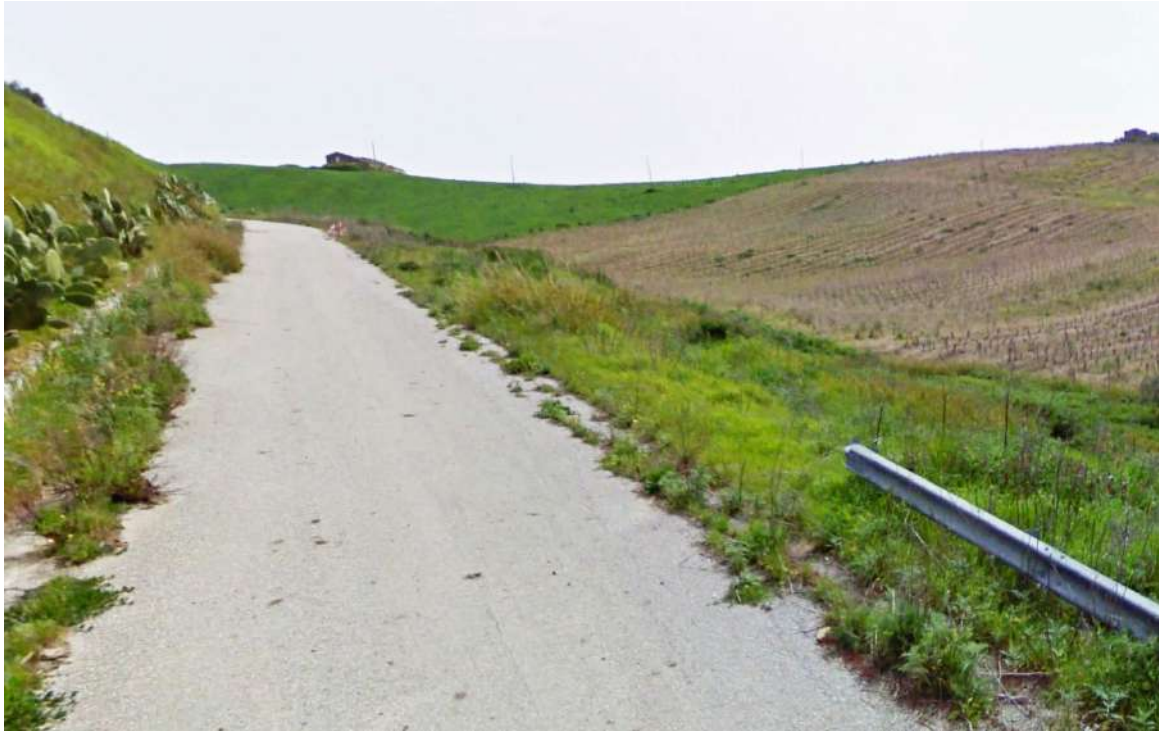
Vista 2 – Stato ante-operam
