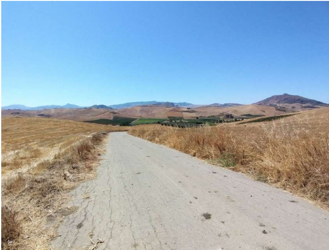
Vista 7 – Stato ante-operam
