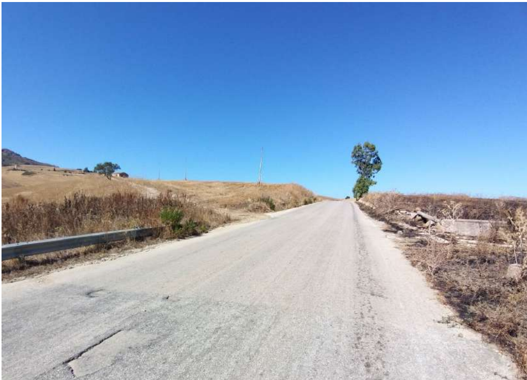
Vista 15 - Stato ante-operam
