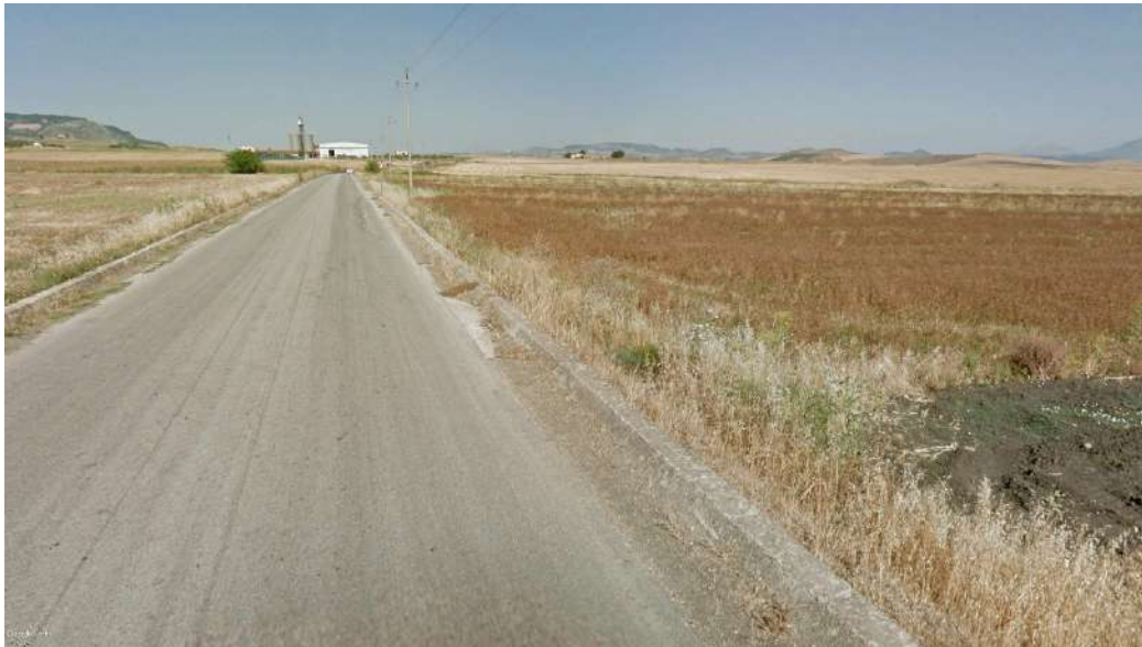
Vista 9 – Stato ante-operam
