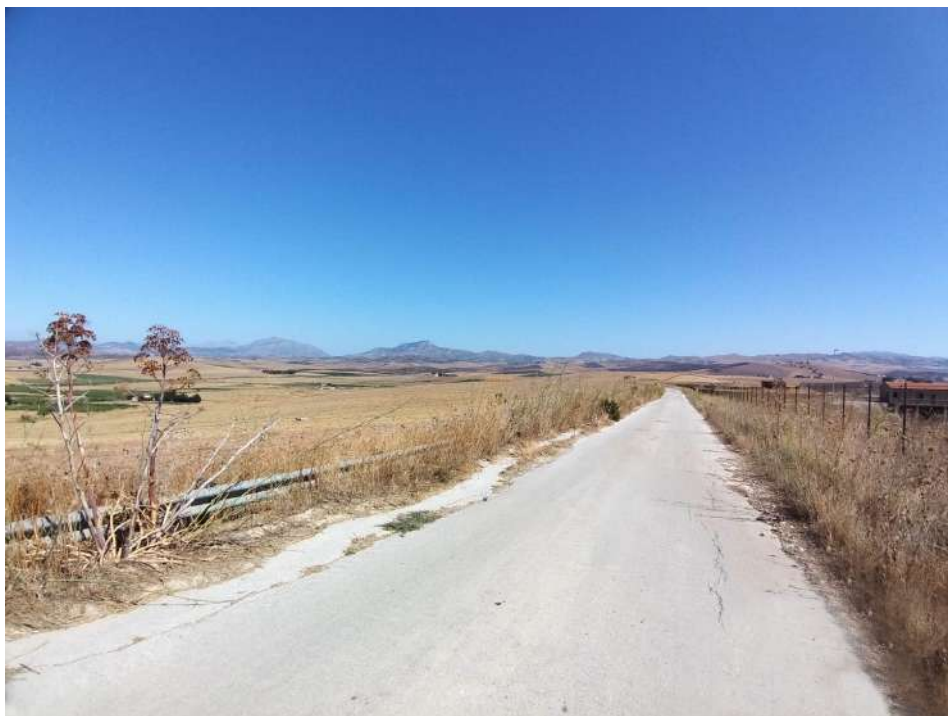
Vista 17 - Stato ante-operam
