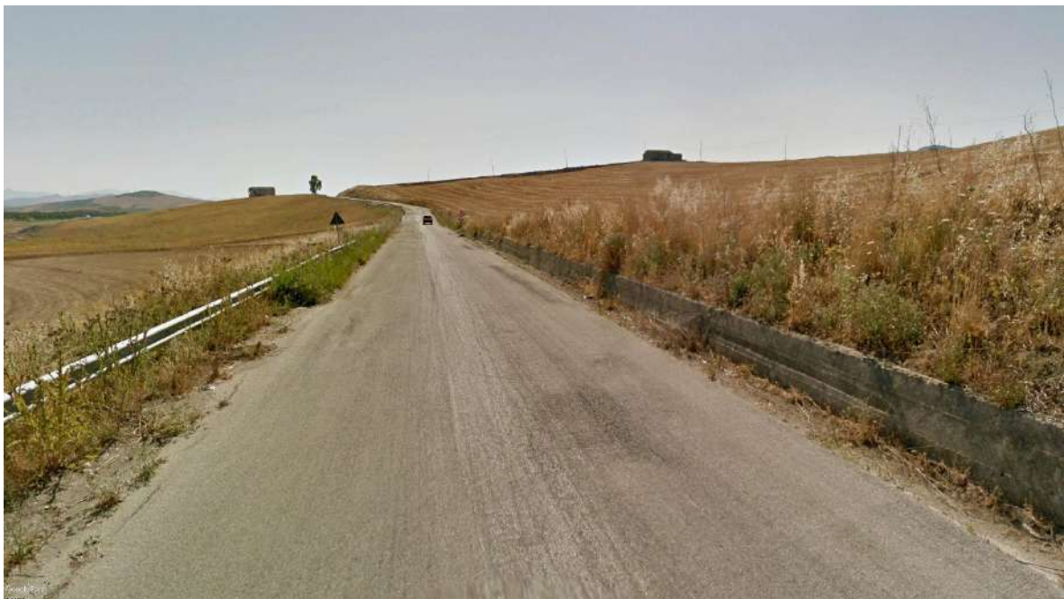
Vista 13 - Stato ante-operam
