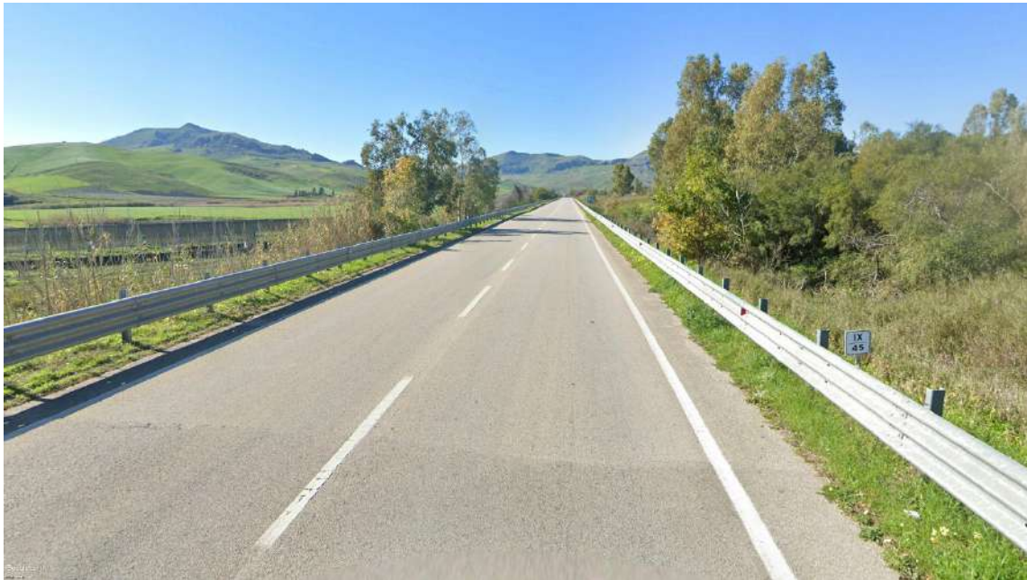
Vista 8 – Stato ante-operam
