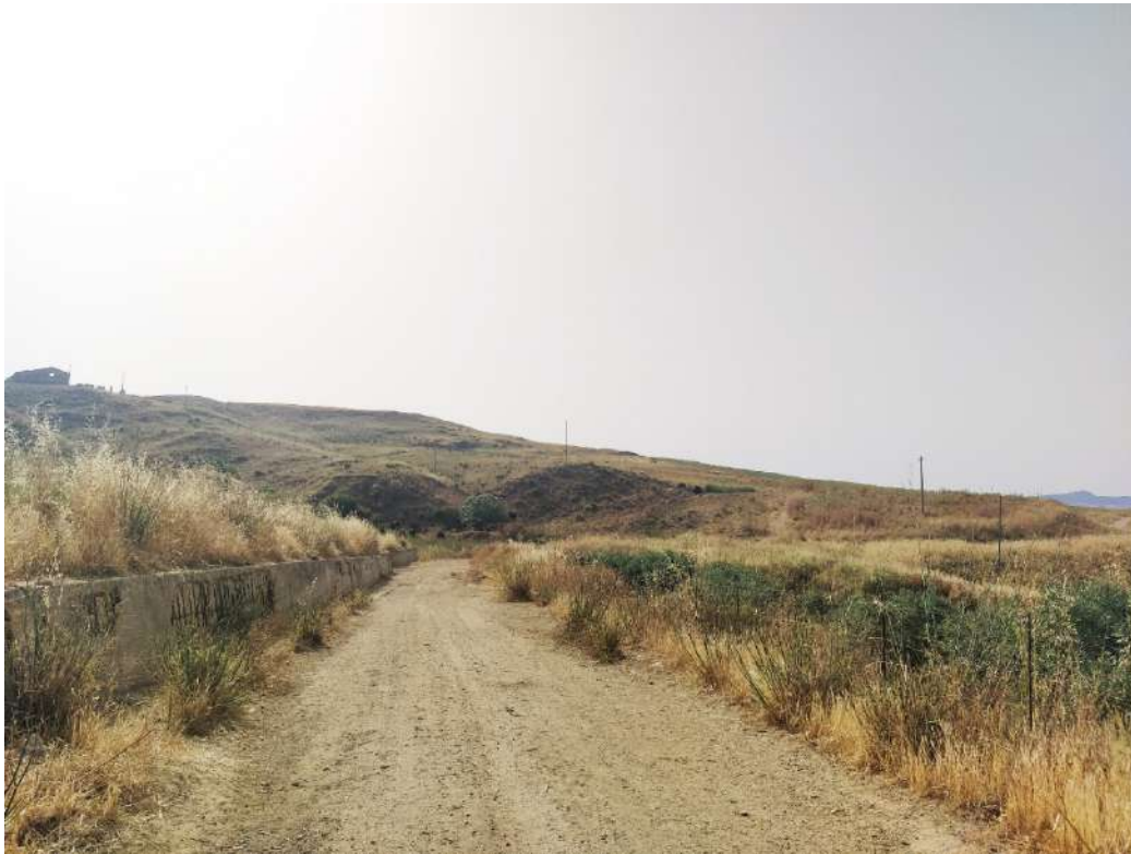
Vista 4 – Stato ante-operam
