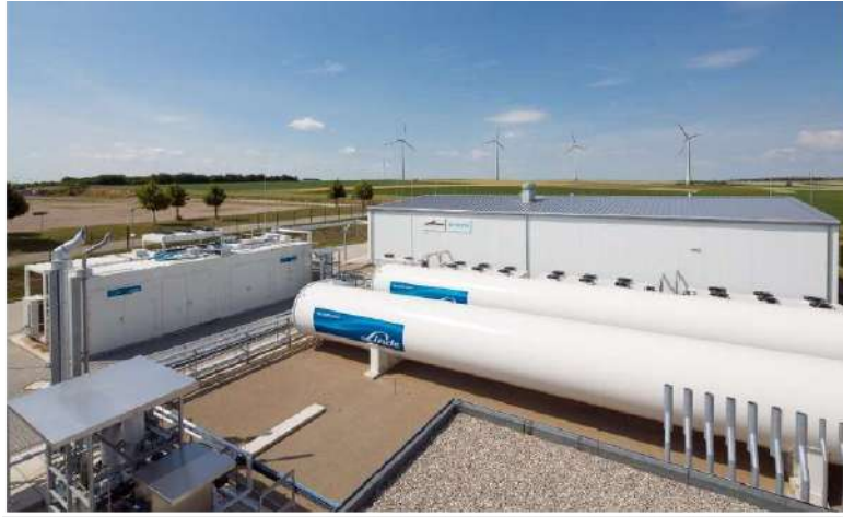
Serbatoi intermedi cilindrici da 82 m 3 tra 20 e 80 bar
