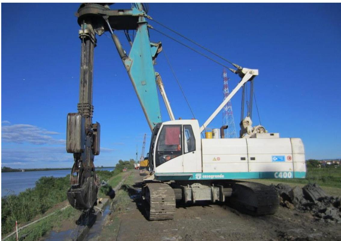
*Fig. 2.4 – Macchinario utilizzato per lo scavo*
