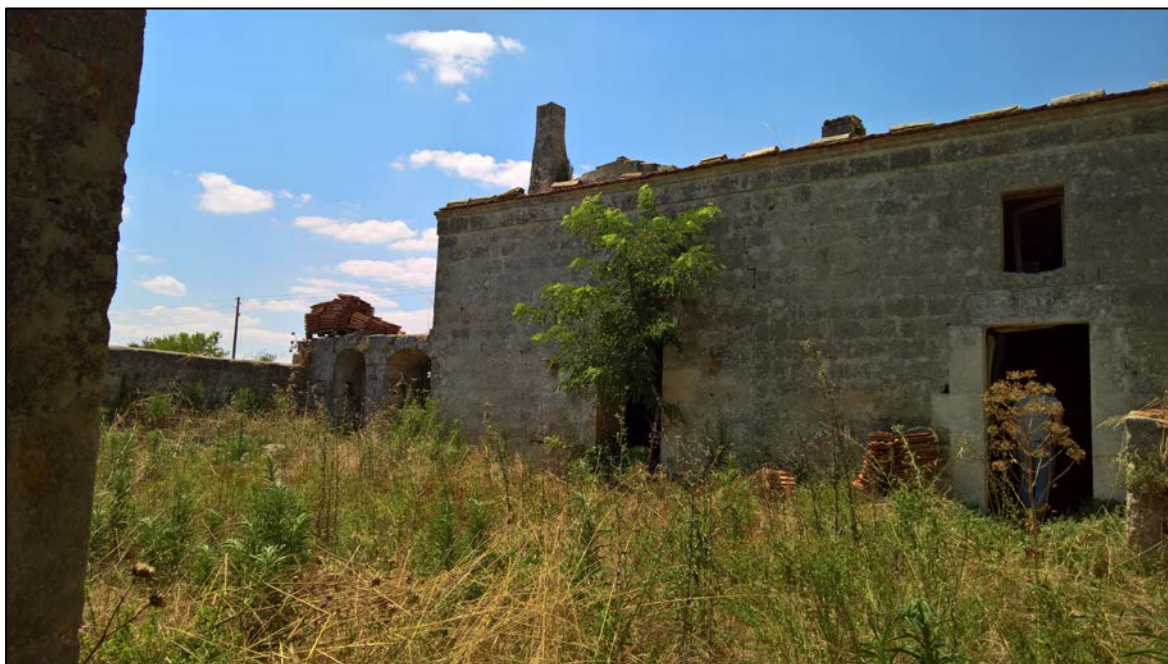
Parte del fabbricato compreso nel lotto di intervento
