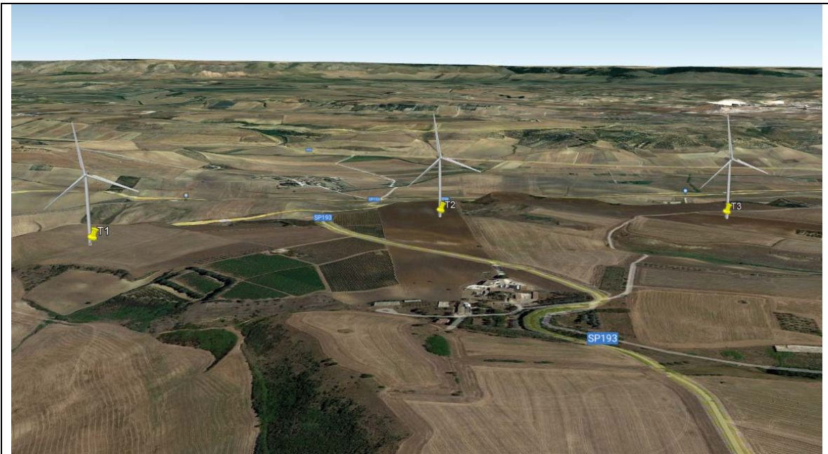
Figura 10 – Vista degli aerogeneratori T1, T2 e T3
