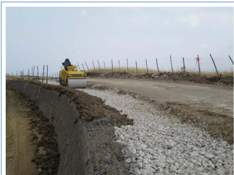
*Figura 32 – Esempio di opera in terre rinforzate - Fonte HE*
