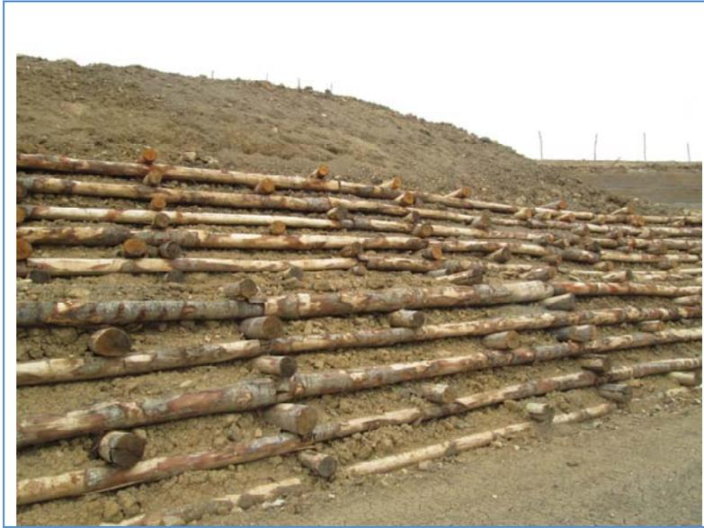
*Figura 31 – Esempio di opera in palificate in legname - Fonte HE*
